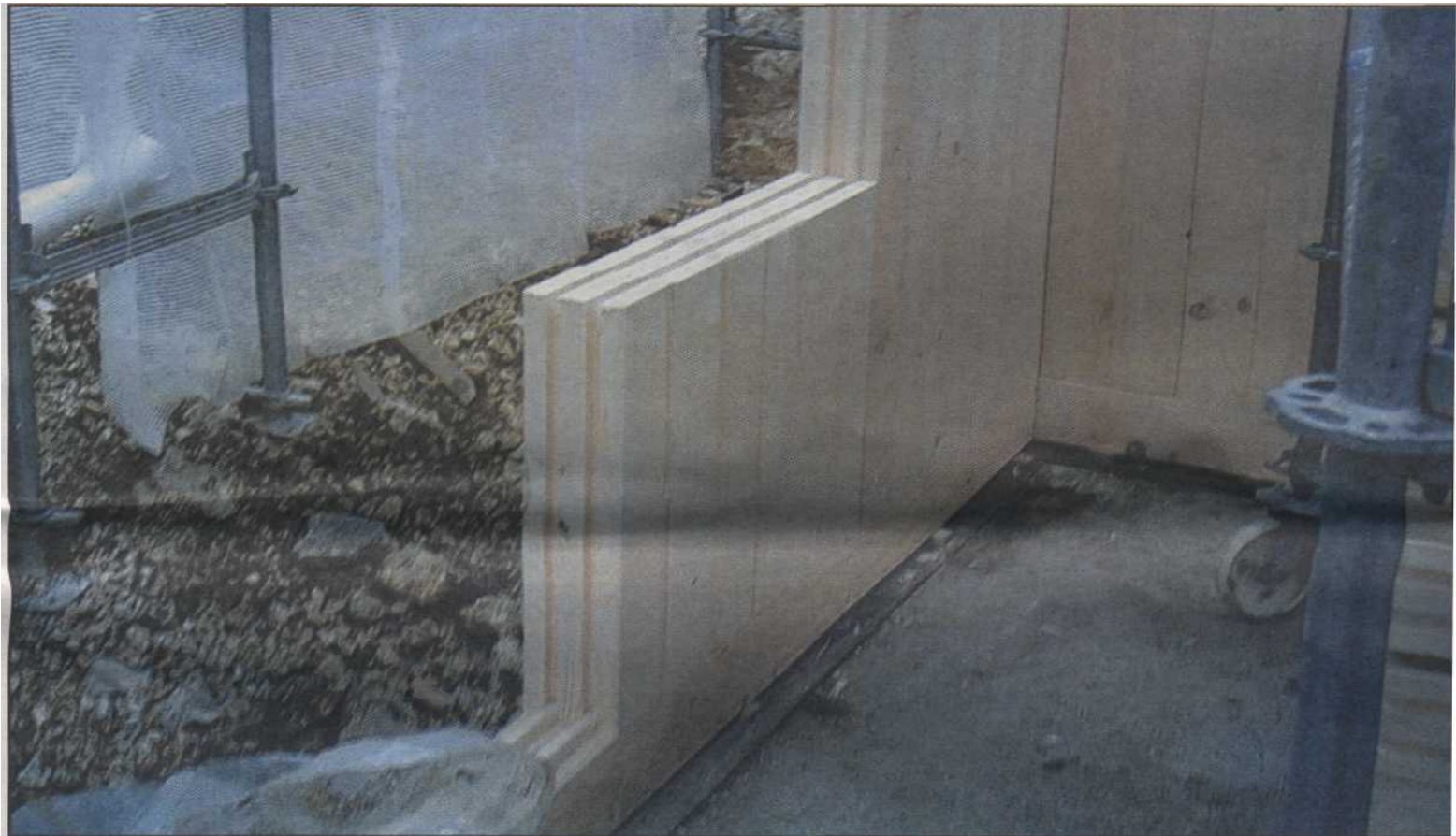
Rainures et crêtes assurent un assemblage rigide, APM R&D, CORCELLES BE.
